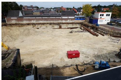
08-09-2018: begin parkeergarage AH
